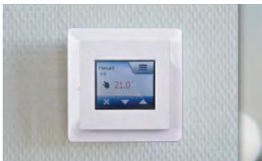
Was im Heizungsraum früher kaum zu verstehen war, ist bei **E-ENERGY** ein kleiner, digitaler und verständlicher Schalter: das **E-ENERGY CARBON** Raumthermostat. Dieses Thermostat sorgt für Energieeinsparung: Es wird schnell aufgeheizt, wenn es zu kühl und abgeschaltet, wenn genug Wärme vorhanden ist.
